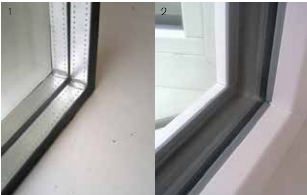
Bild 1: herkömmlicher Aluminium-Abstandhalter
